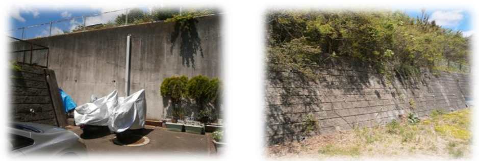
現地写真: 南側コンクリート擁 北側の間知ブロック
